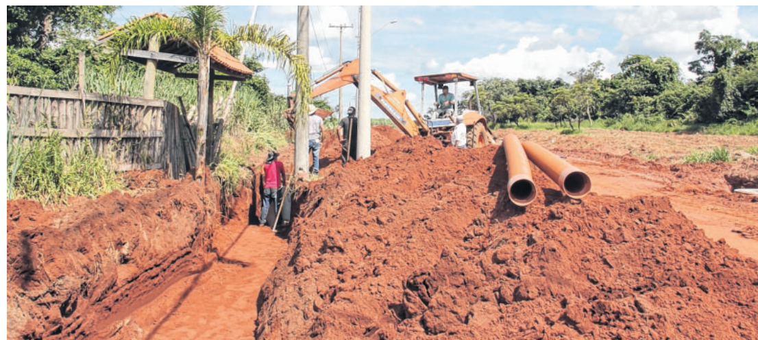
Tubulação de esgoto e água potável está sendo instalada, assim como já foi feito o sistema de drenagem
