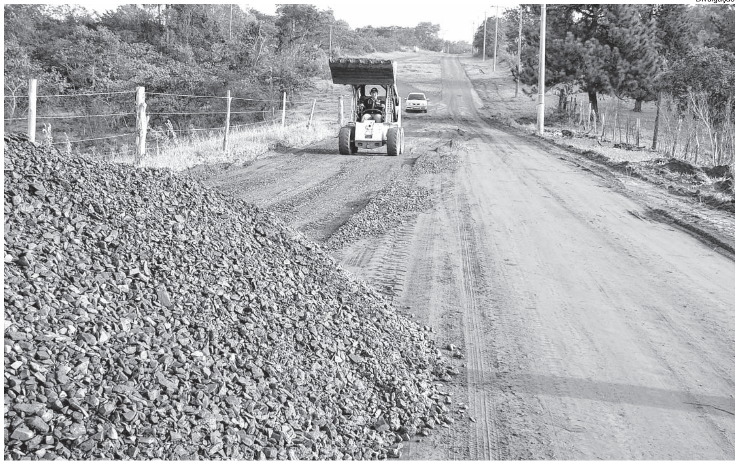
Mesmo com o início chuvoso do inverno em Bauru, empresa começou as obras no local com a terraplanagem do solo
